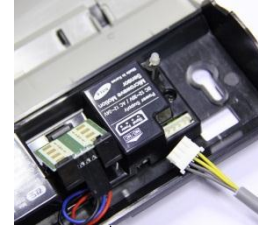
1. เชื่อมต่อสายไฟ
